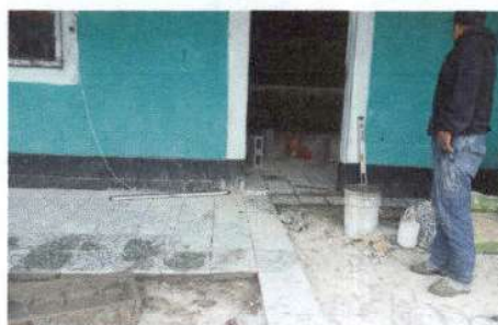
Foto4: Sustrucción de piso de granito.
