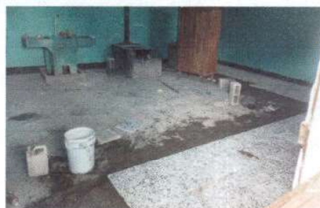
Foto2: Sustrucción de piso de granito.
