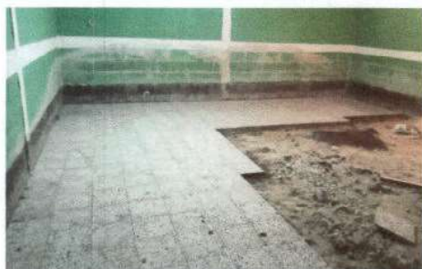
Foto1: Sustrucción de piso de granito.
