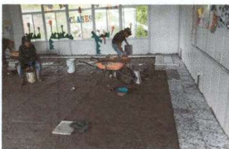
Foto5: Sustrucción de piso de granito.
