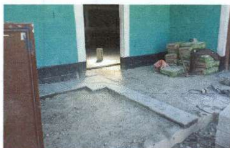
Foto3: Sustrucción de piso de granito.
