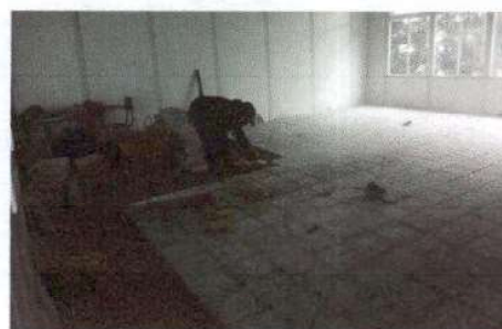
Foto6: Sustrucción de piso de granito.
